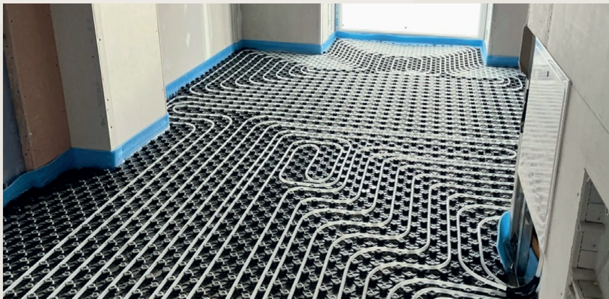
Instalación de suelo radiante en Bravo Murillo (Madrid).
